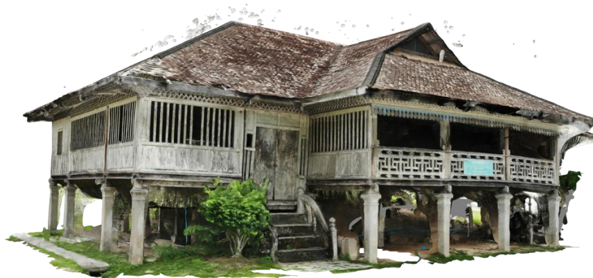
รูปที่ 6 แบบจำลองพอยต์คลาวด์ที่มีความหนาแน่นสูงขึ้น หอฉันทรงเรือนไทย วัดแหลมทราย (Autodesk Recap Pro Photo)
